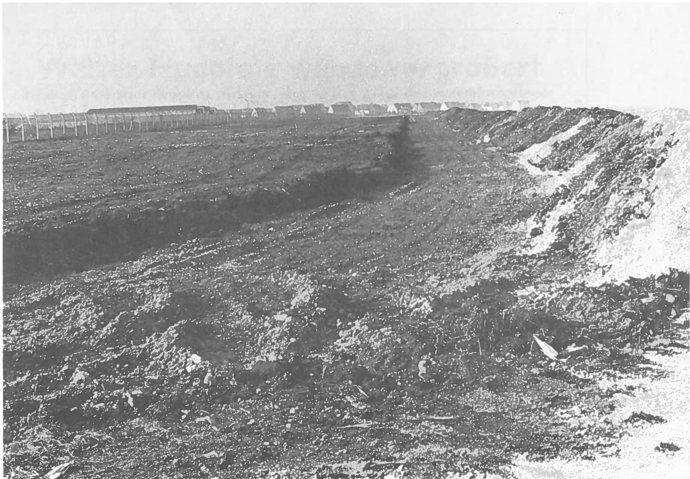
Keine Mondlandschaft, sondern die Aushubarbeiten für den Westrollweg (A)
